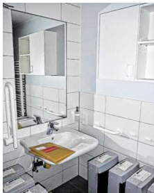
Die Fertigbäder wurden komplett per Kran in die Baustelle eingehoben.
