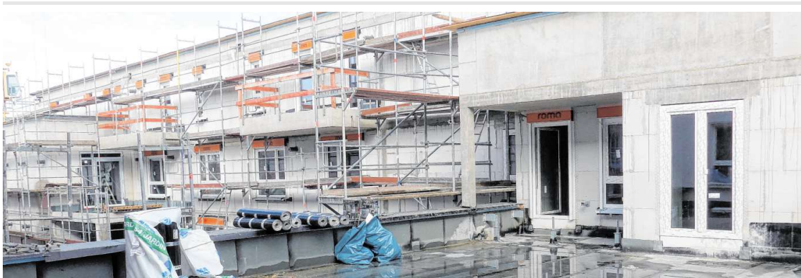
Blick auf die Gemeinschaftsterrasse des Neubaus, der Platz für 100 Pflegezimmer und 31 Wohnungen bietet. Bis Ende des Jahres soll er belegt sein und liegt damit gut im aufgestellten Zeitplan.
