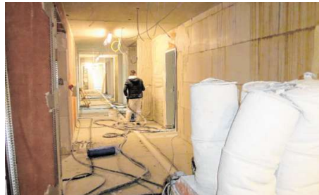
Im ersten Obergeschoss des Neubaus wird derzeit der Streichputz aufgesprüht. Anschließend können die Maler die Regie übernehmen und die Wände gestalten.
