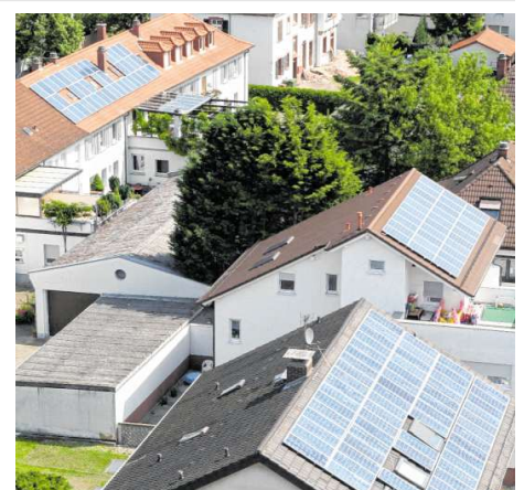
Der Blick vom Wasserturm zeigt: Photovoltaikanlagen sind bereits auf vielen Dächern in Hockenheim installiert. Es gibt aber auch noch großes Potenzial.
