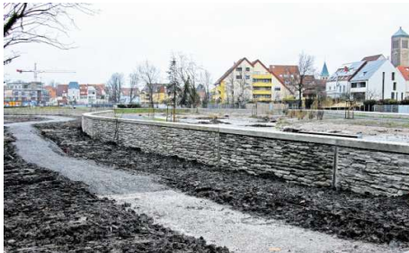
Die Hochwasserschutzwände sind in Natursteinoptik verkleidet worden.
