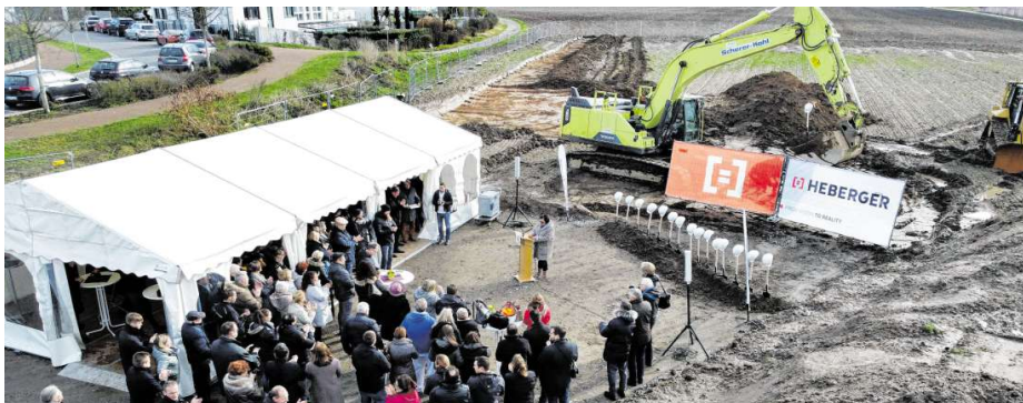
Die Baustelle ist eingezäunt, die Bagger stehen bereit: Manuela Offenloch (am Pul) begrüßt die Spatenstich-Gäste im Gebiet „Biblis IV. Gewann“, für die vorsichtshalber ein Zelt aufgestellt wurde. Am oberen Bildrand sind die Häuser und Gärten der Wilhelm-Hertz-Straße sowie das Feld, das sich Richtung Reilingen erstreckt, zu erkennen. BILDER: LENHARDT
