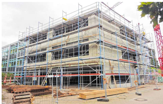
Der Rohbau hat mit drei Geschossen seine endgültige Höhe erreicht. BILD: DUFFIN
