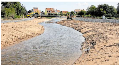
Der Kraichbach in seinem neuen Bett. Links und rechts davon werden noch die Dämme fertiggestellt. Im Hintergrund sieht man die neue Brücke.
