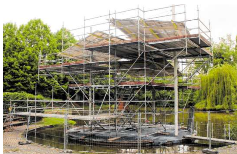
Das Gerüst an der Seebühne steht, die Dacharbeiten beginnen. BILD: GÖTZMANN
